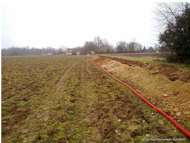
1 h pour dérouler le câble sur toute la longueur et 2 h pour le faire passer dans la gaine
