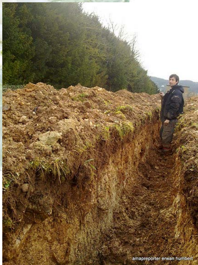
Vue de la profondeur creusée
