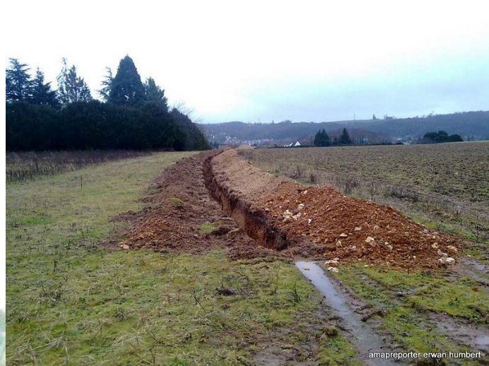
La tranchée dans laquelle il faut faire passer câble électrique et tuyau d'irrigation mesure 180 m de long,
