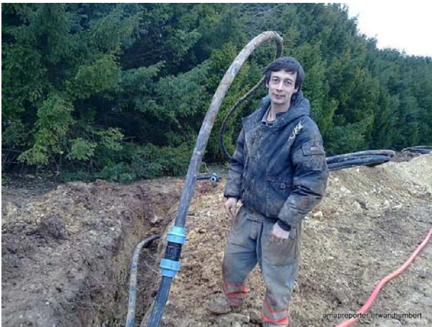
Xavier est fatigué, mais le passage des tuyaux est terminé
