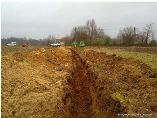
Xavier aux commandes de la pelleteuse pour creuser les tranchées nécessaires à la pose du tuyau d'irrigation et du câble électrique
