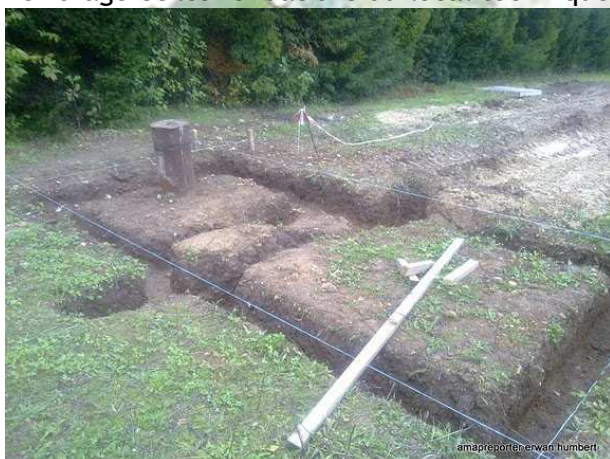
Le forage et les fondations du local technique
